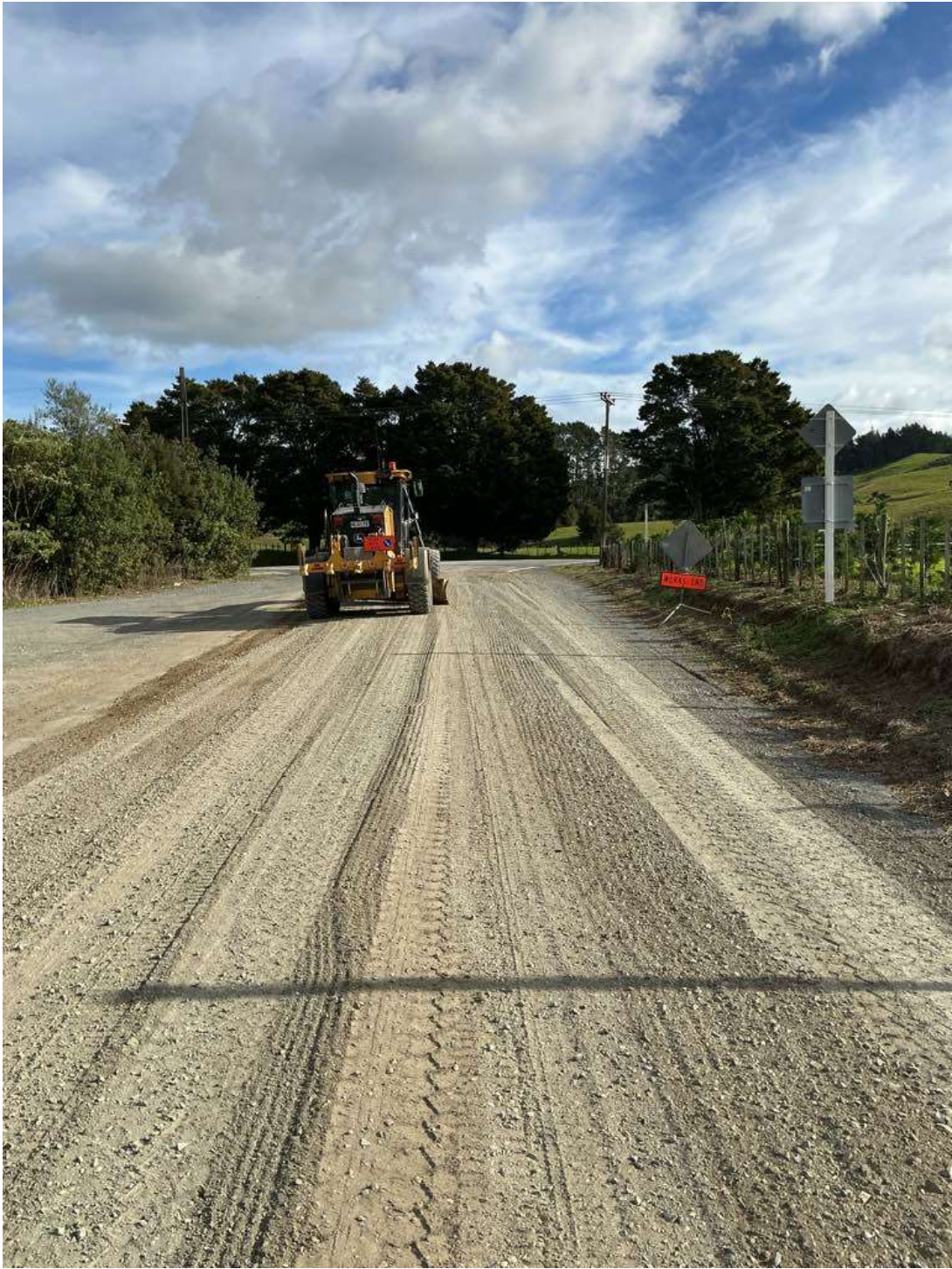
Dangen Rd - Grading
