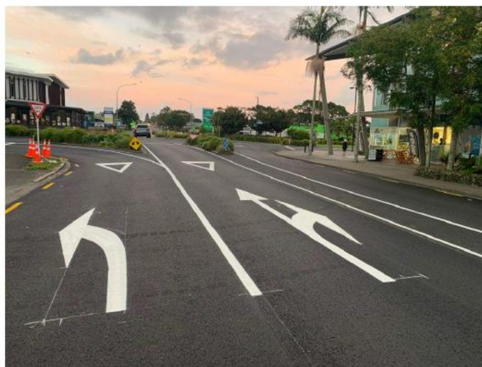
Kerikeri Rd – Asphalting/Line marking
