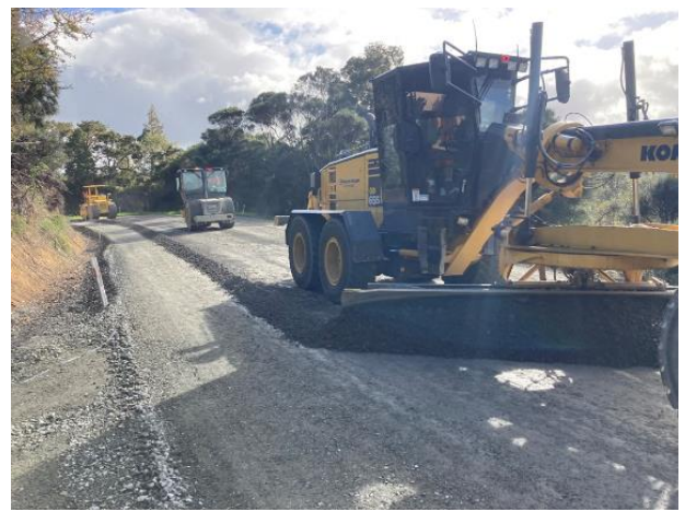
Figure 9: Kohukohu Rd Rehab Stabilisation
