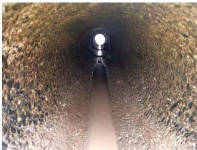
Hautapu Rd – Culvert Flushing
