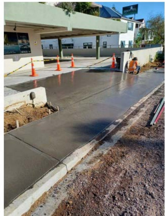
Kings Rd – Footpath Prep and pour
